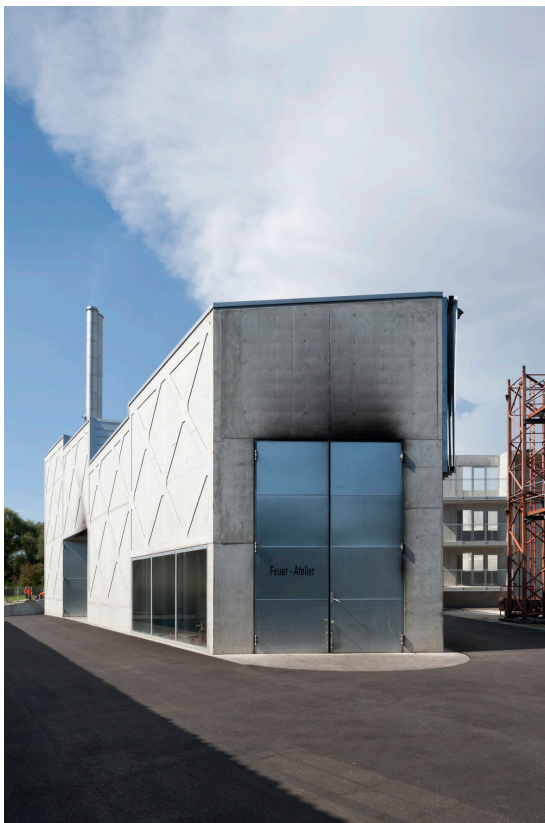
— Ansicht Südost — Flashoverhalle — Ansicht Ost
